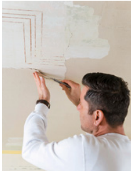
Vorbereiten: Der abblätternde Putz muss weggeschabt werden.
