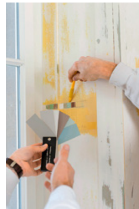
Abstimmen: Sechs Farbschichten liegen auf dem Täfer. Mit der Farbpalette wird nun die unterste, ursprüngliche Farbe bestimmt.
